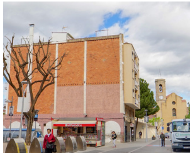
En la imatge superior, la mitgera de l'edifici del carrer del Bon Viatge on es pintarà el mural commemoratiu
